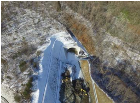
(仮)小山田トンネル 宮古側
